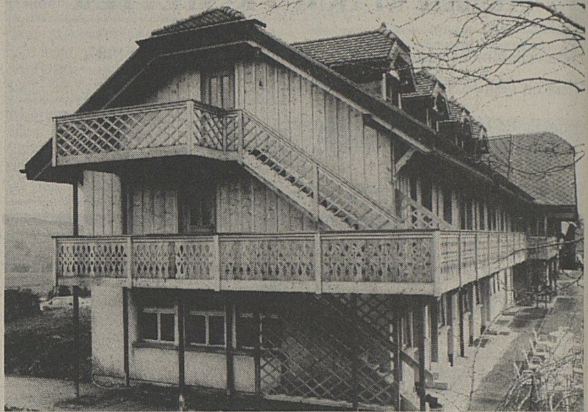
La restauration à la tronçonneuse: pas le meilleur remède pour les Colombettes. Alain Wicht-
